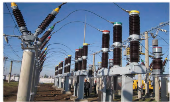
图9 西安交通大学 126 kV 真空断路器
