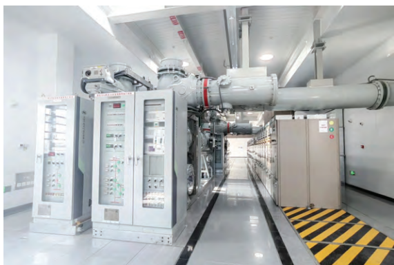
图 11 平高 126 kV 无氟环保型 GIS
