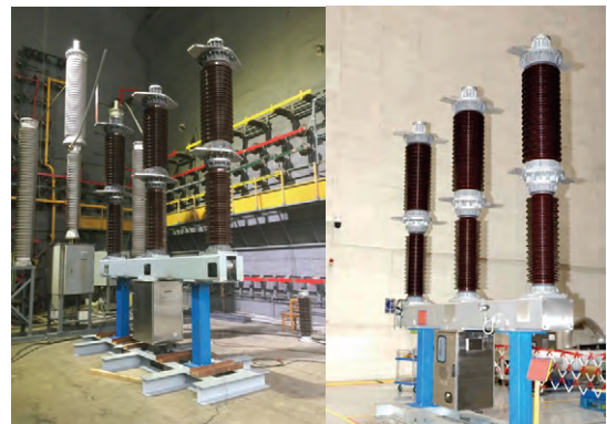
图8 西开有限 126 kV 真空断路器
