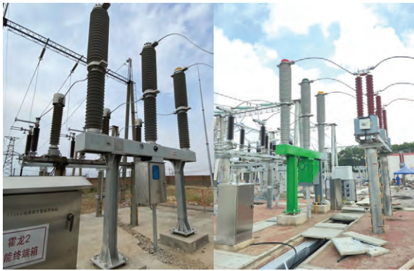
图 10 平高 126 kV/145 kV 真空断路器
